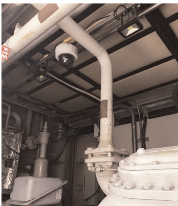
カメラを取り付けた冷凍機。センサーも付けて遠隔監視することで設備異常の兆候をキャッチ
